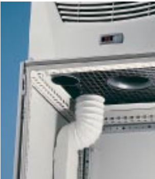
通过导流管有针对性地供应冷空气。
