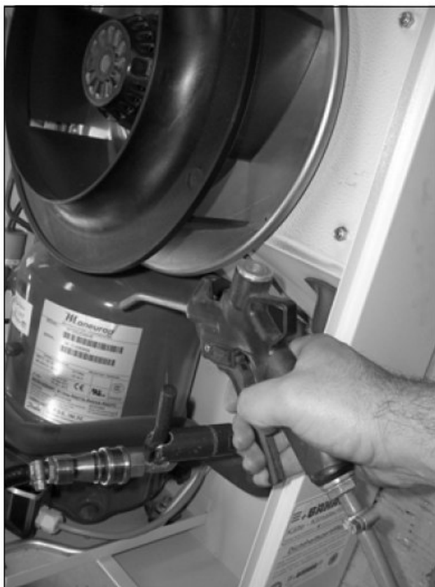
图56：用压缩空气清吹热交换器盘管和压缩机室 (2)
