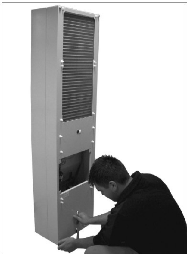
图74: 松开盖子上的四个螺钉
