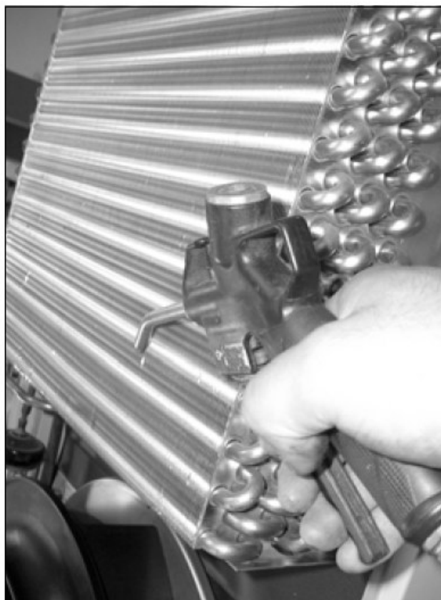
图79: 用压缩空气清吹热交换器盘管和压缩机室 (2)
