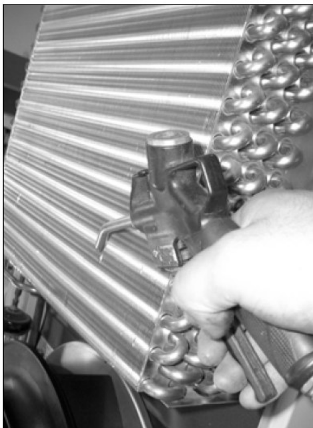
图55：用压缩空气清吹热交换器盘管和压缩机室（1）
