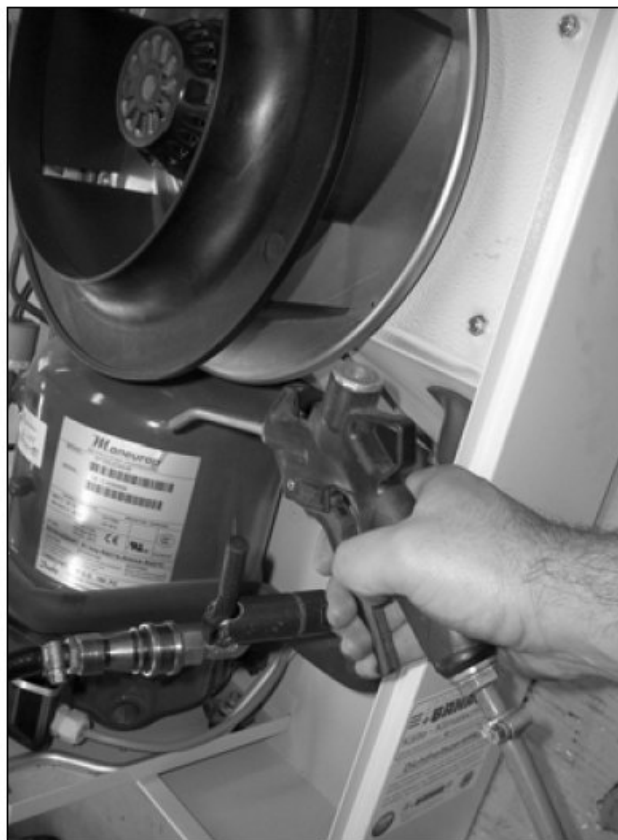
图80: 用压缩空气清吹热交换器盘管和压缩机室 (3)
