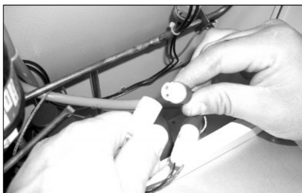
图71: 断开风扇接头 (3)
